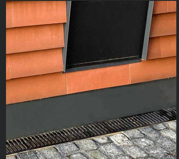
| Entwässerung im Sockelpunkt
