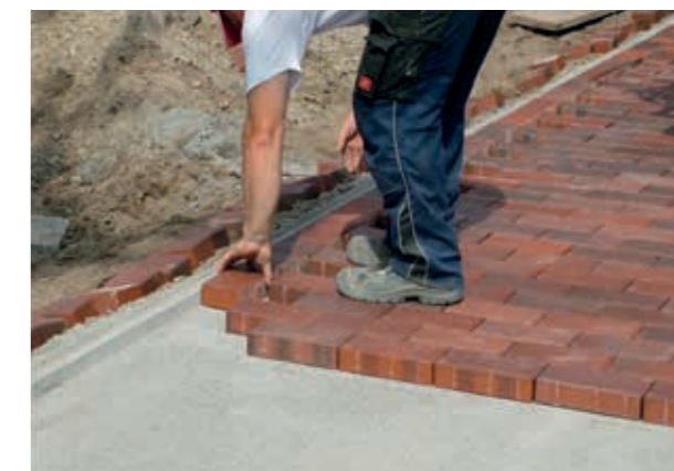
Abb. 5-11: Handverlegung von Pflasterklinkern
