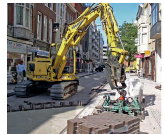
Maschinenverlegung von Pflasterklinker, Den Haag, Niederlande
